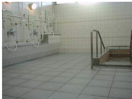
介護施設 洗い場、浴槽床面への施工例
