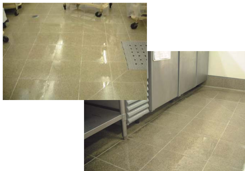
厨房施設床面 アベイラス・ハードタイプによるリフォーム施工例
