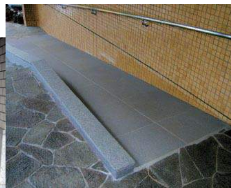
マンションスロープ施工例
