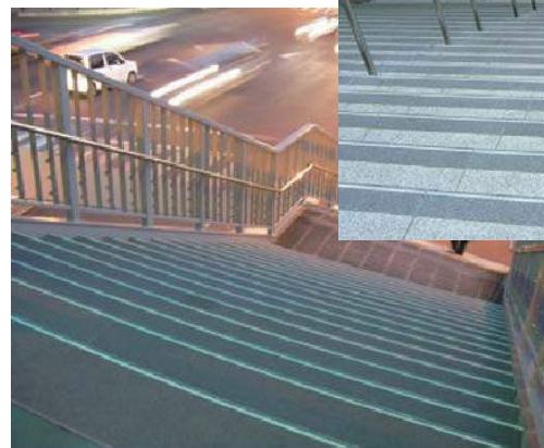
駅階段 蓄光式防滑階段のアベイラス・ ハードタイプによるリフォーム施工例
