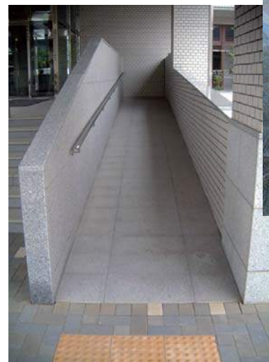
介護施設スロープへの施工例
