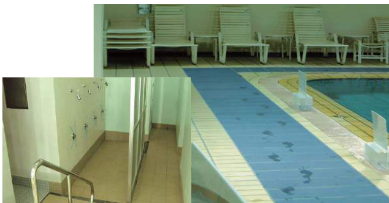
プールサイド床面 アベイラス・ハードタイプによるリフォーム施工例
