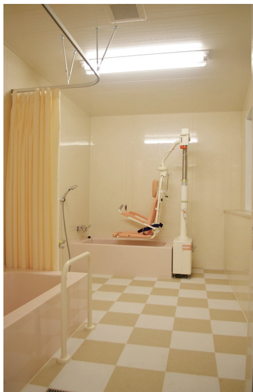
介護施設の浴室床材として使用
